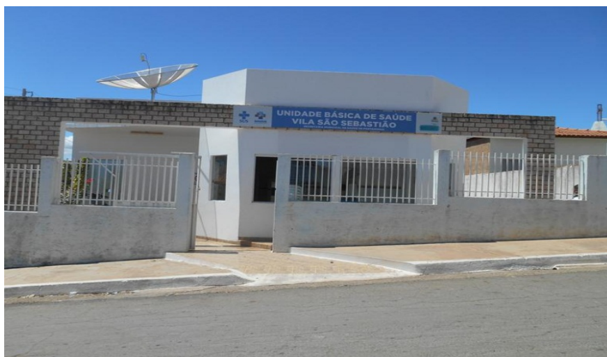
Figura 2 – Fachada da Unidade Básica de Saúde São Sebastião do município de Porteirinha – Minas Gerais
