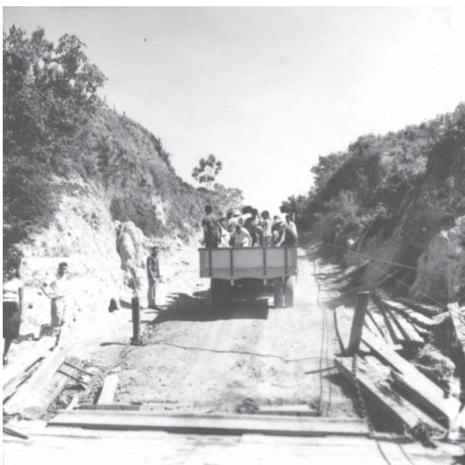
Trabalhadores transportados em caminhão para a construção da BR-29, Rodovia Acre-Brasília. Acervo IBGE.
