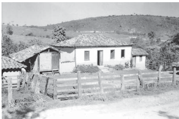
Casa típica do interior de Minas Gerais, 1958. Acervo IBGE.
